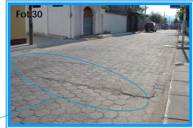
**FOTOGRAFÍA No.29,30:** El mal estado del adoquín, las reparaciones superficiales a las cuales están sometidas las calles no obstante no han sido compuestas a su totalidad ya que se observa que carece de uniformidad. Fuente de elaboración propia. Marzo 2008.
