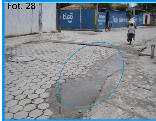
**FOTOGRAFÍA No. 28:** El mal estado del adoquín, Las reparaciones superficiales a las cuales están sometidas las calles, no obstante, no han sido compuestas a su totalidad ya que se observa que carece de uniformidad. Fuente de
