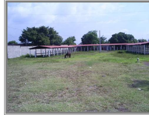
Esta es el área destinada a la exposición de ganado. Cuenta con 3 galeras aproximadamente 30 metros de largo por 6 metros de ancho la cubierta de éstas es de estructura metálica y techo de lámina.
