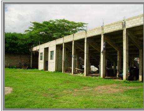
La construcción actual del coliseo fue hecha con block de pómez y concreto reforzado, las columnas que sostienen el graderío tienen una altura de 5.00 metros, y están moduladas a distancia de 2.60 metros. Bajo los graderíos se encuentran ubicados los S.S.
