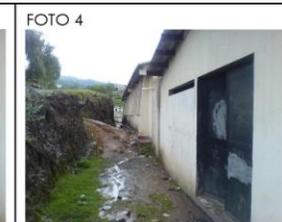
No se tiene el uso de muros de contención en los laterales del edificio, con la acumulación de erosión puede tener riesgo de deslizamiento.
