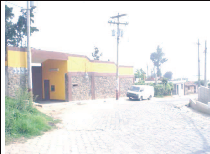
Foto 3. Fachada del Centro, ingreso, registro y garita de seguridad del centro. Se observan muros altos, un único ingreso vehicular y peatonal.
