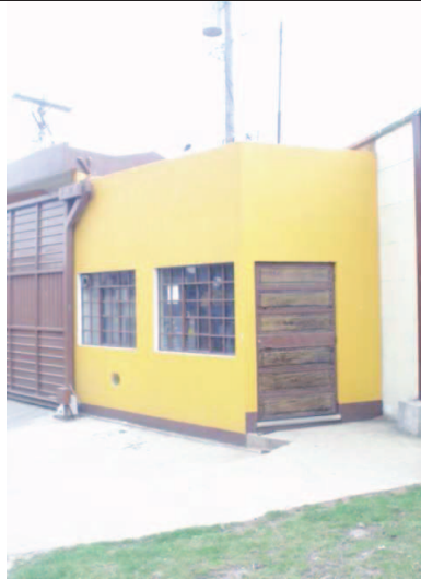
Foto 11. Lavandería general, para Nivel I y Nivel II. Esta área sí es manipulada por una persona del personal de mantenimiento por los tipos de niveles a los que sirve.
