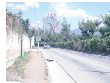
FOTO No. 31 FUENTE: Propia VÍA PRINCIPAL ASFALTADA
