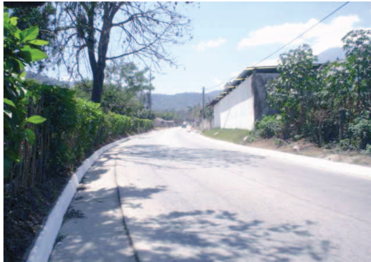
FOTO 52 TIPO DE TRÁNSITO EL TRÁNSITO VEHICULAR HACIA SAN JUAN EL OBISPO Y ALDEAS VECINAS NO ES TAN ALTO, LAS VIVIENDAS VECINAS TIENEN UN RETIRO DEL FINAL DE LA CALLE DE 1mt.
