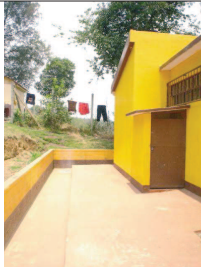
Foto 23. Tipo de Circulación, evitar su escape no es tan primordial, por lo que los muros que limitan el área son de baja altura.
