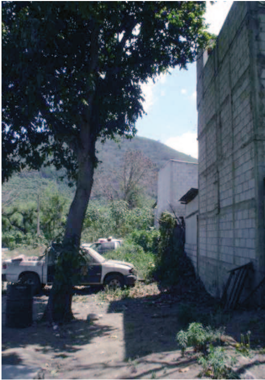
FOTO No.50 PARED COLINDANTE NOR-OESTE PARTE DE LA CHATARRA DE CARROS SE ENCUENTRA EN ESTE SECTOR
