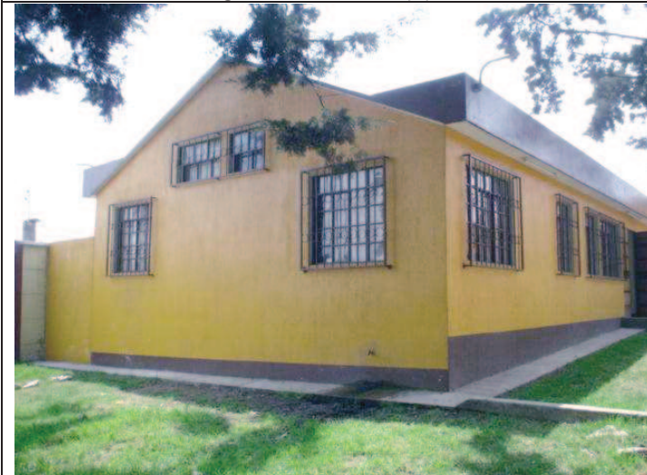
Foto 5. Áreas administrativas, se encuentran ubicadas en el ingreso y por la misma es el ingreso peatonal.
