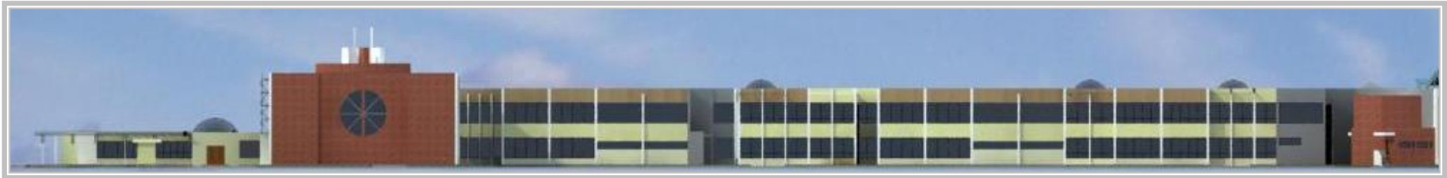
VISTA SUR CONJUNTO ADMINISTRACIÓN BIBLIOTECA Y SALONES
