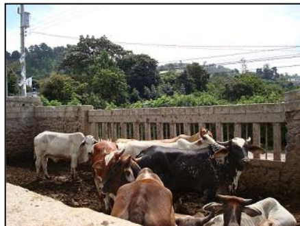
FOTOGRAFÍA No. 4: Estado actual de los corrales.
