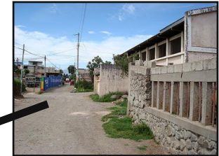
VISTA C: Vista frontal del Rastro Municipal, Área de Corrales
