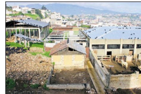
FOTOGRAFÍA No. 5: Esta vista panorámica del rastro de Quetzaltenango demuestra la falta de control y cumplimiento de medidas sanitarias, entre las cuales mencionamos: - Los desechos de los animales son tirados atrás del rastro. - No hay control de aves rapaces (zopilotes) y perros. - El rastro se encuentra frente a una escuela, donde los estudiantes se ven afectados por los olores fétidos. (Foto PL: Mynor Toc. Fuente: Prensa Libre: Guatemala, 13 de agosto de 2007).
