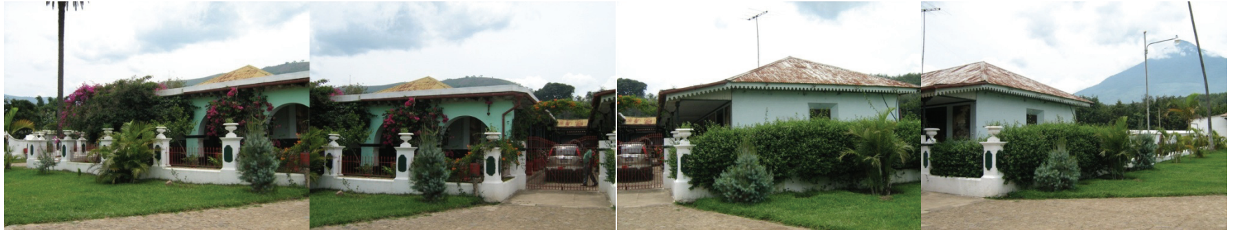
Fachada Oeste Casa Patronal
