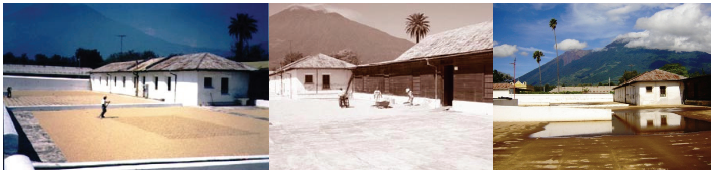
Fachada Sur Casa Patronal
