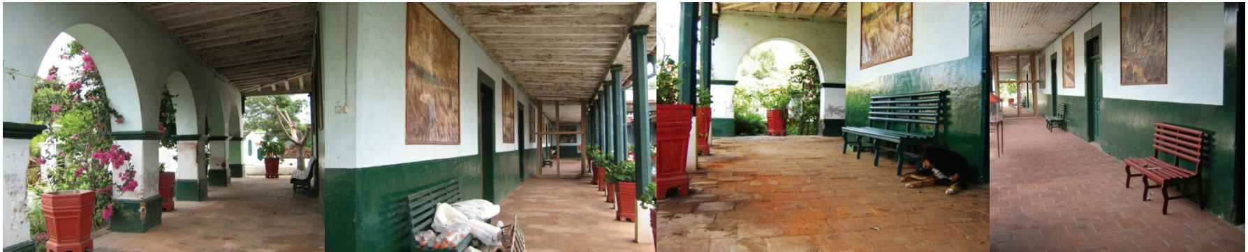
Pasillo Interior Oeste Casa Patronal
