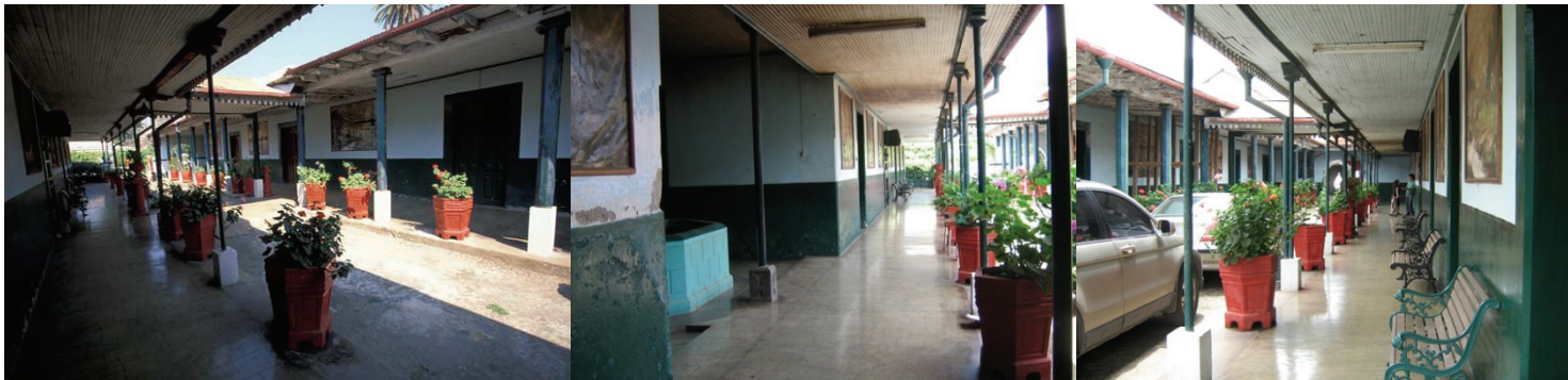
Pasillo Interior Sur Casa Patronal
