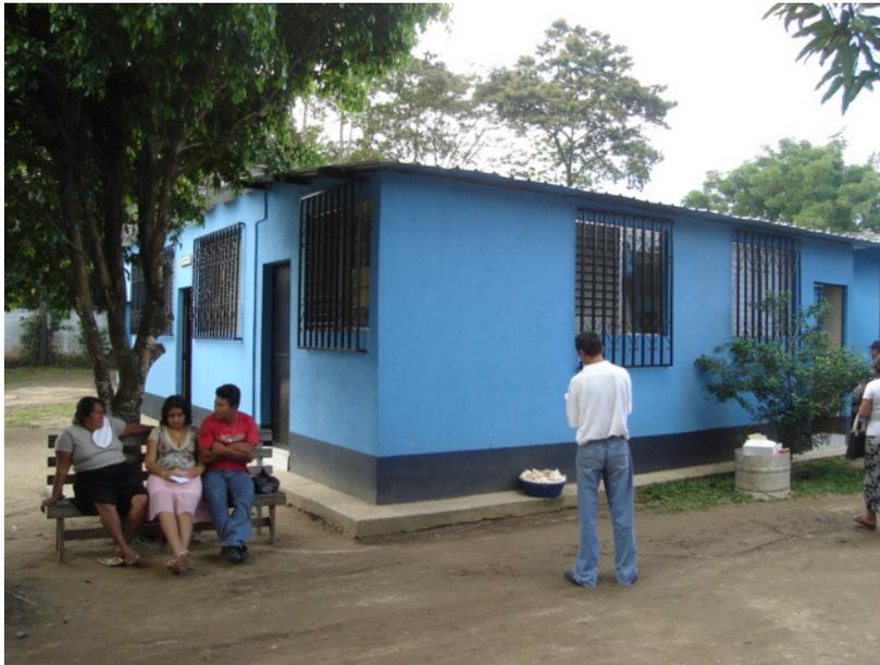
**FOTOGRAFÍA NO. 11** Esta imagen muestra el edificio de laboratorios del Centro de Salud, una de las áreas fue agregada a la construcción original, se observa por la junta constructiva que se ve al lado de la puerta de ingreso, la construcción nueva se hizo con lámina metálica y no lámina canaleta como el resto de la construcción.
