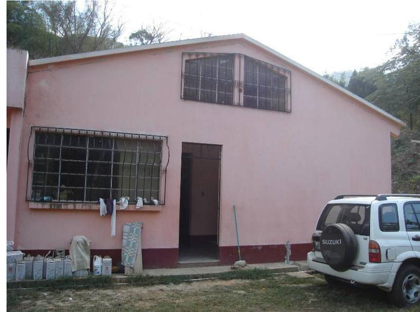
**FOTOGRAFÍA NO. 38:** Esta imagen muestra la parte exterior de la consulta externa, la ventilación de la sala de espera se hace a través de estas ventanas colocadas en la parte más alta de los muros.
