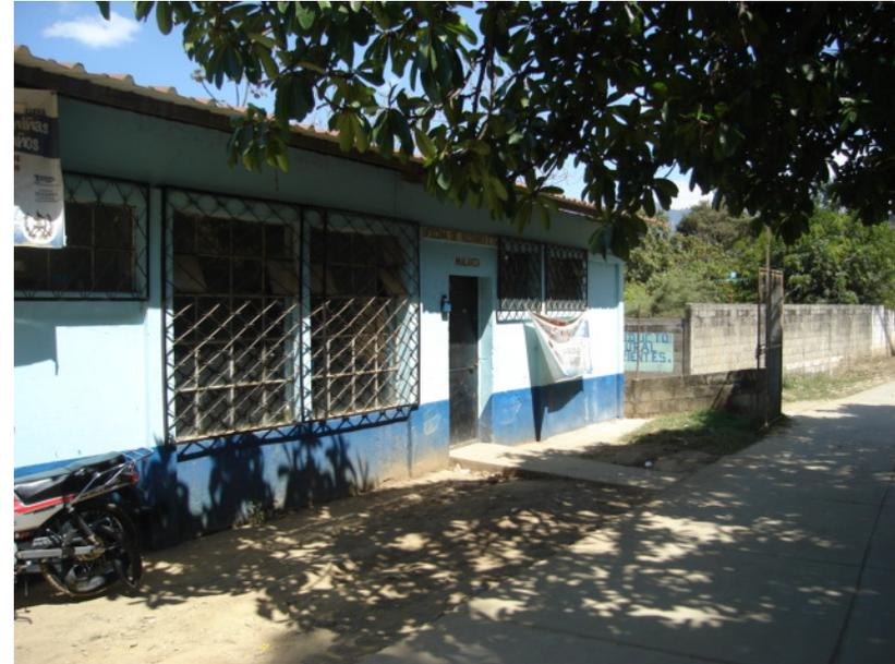
**FOTOGRAFÍA NO. 24:** Esta imagen muestra el sistema constructivo del Centro de Salud, es de block + concreto + lámina metálica para el techo. También existe un poco de humedad en la parte baja de los muros.
