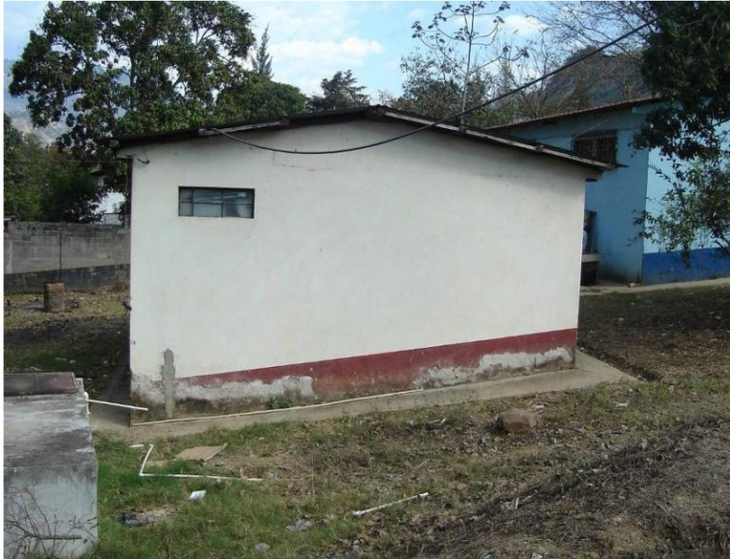
**FOTOGRAFÍA NO. 37:** Esta imagen muestra que el desnivel del terreno es bastante pronunciado, además, al igual que el resto del proyecto, este edificio tiene problemas de humedad en la parte baja de los muros.
