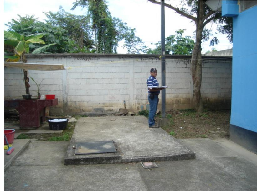
**FOTOGRAFÍA NO. 20** Esta imagen muestra la cisterna del Centro de Salud, la cual es de concreto, el único problema con esta cisterna es que se encuentra ubicada al fondo del terreno, lo que hace muy difícil su mantenimiento, además de hacer más difíciles futuras ampliaciones, ya que se encuentra entre 2 edificios.
