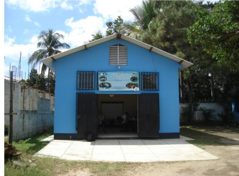
**FOTOGRAFÍA NO. 4:** Se puede ver el área nueva del Centro de Salud, la sala de juntas, es una construcción donada por una ONG. Este es el sistema constructivo usado en el Centro de Salud, block y lámina, en esta construcción se uso lámina metálica, pero en el área hospitalaria se uso lámina canaleta.
