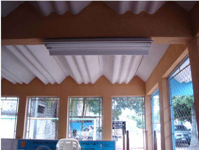
**FOTOGRAFÍA NO. 13** En esta imagen se observa el techo del área de vectores, se observa la lámina canaleta y vigas de concreto que la sostienen.
