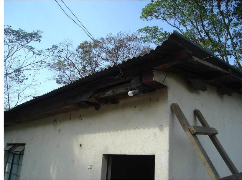
**FOTOGRAFÍA NO. 36:** Esta imagen muestra parte del techo de la sala de partos, esta muy descuidado y deteriorado, no se le ha dado ningún tipo de mantenimiento.
