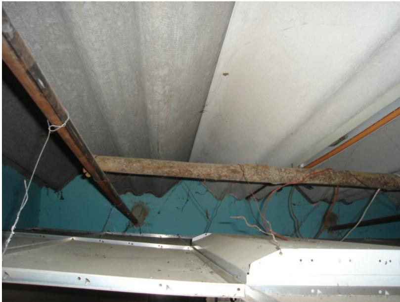
**FOTOGRAFÍA NO. 7** Las tuberías de las instalaciones pasan en el espacio entre el cielo falso y la lámina canaleta. Esto es muy usual y aconsejable en la arquitectura hospitalaria.
