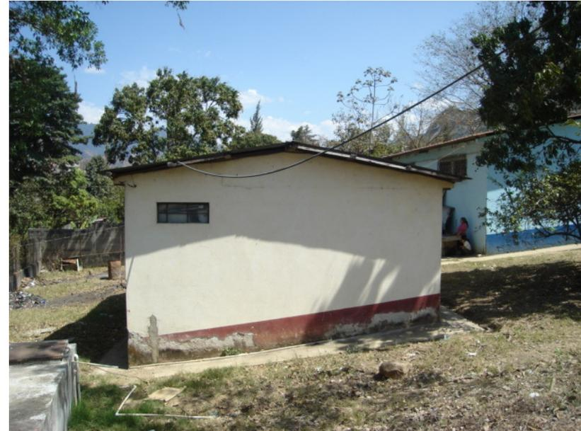
**FOTOGRAFÍA NO. 28:** Esta imagen muestra la edificación donde se encuentra la sala de partos del Centro de Salud, tiene mucha humedad en la parte baja de los muros, además de que los muros no han sido cuidados apropiadamente.
