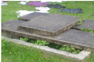
Foto No. 12. Reposadera.
