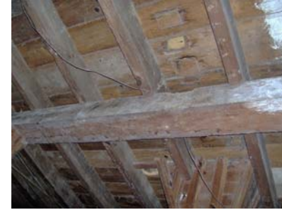
Foto No. 17. Techo Área de Comedor
