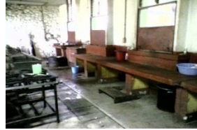
Foto 16. Área de Cocina.
