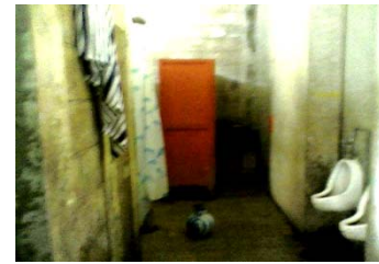
Foto No. 13. Sanitario de Hombres.
