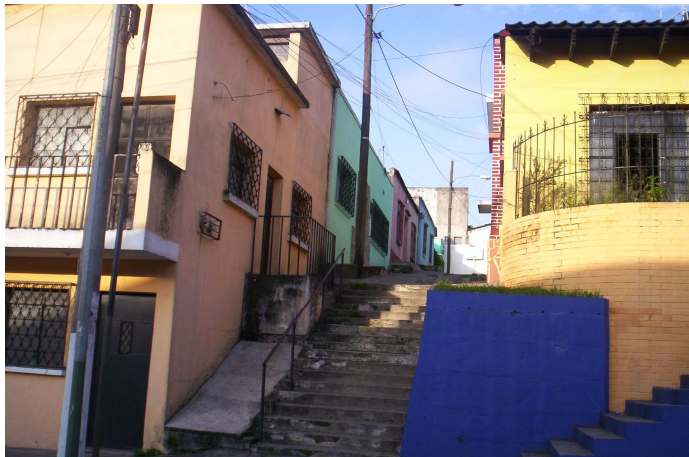
Fotografía No. 6.4 Callejón sin salida ubicado sobre la Vía 5 A Fuente: elaboración propia.
