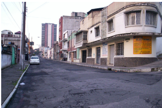
Fotografía 6.1 Corredor urbano de la 9na Avenida, vista hacia el Sur Fuente: elaboración propia
