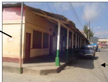
Fotografía 49: Vista de Locales Comerciales en la Fachada principal
