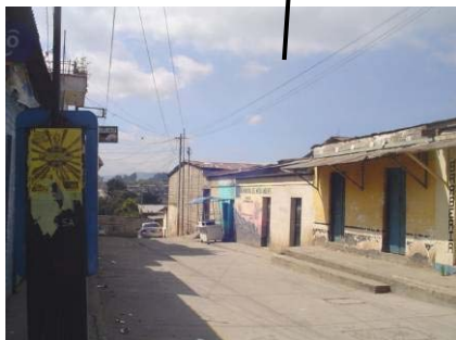
Fotografía 50: Vista Sur del Mercado Municipal, actualmente a pesar de ser locales puerta a calle, funcionan como bodegas.
