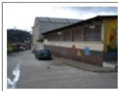
Fotografia No. 1 Contiguo a la escuela se encuentra el edificio municipal, el cual no representa ningun peligro para esta edificacion.
