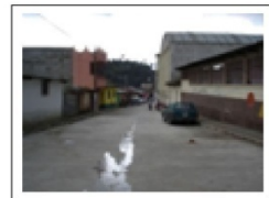
Fotografia No. 2 La calle lateral se encuentra pavimentada y las viviendas no representan ningun peligro para la edificacion.
