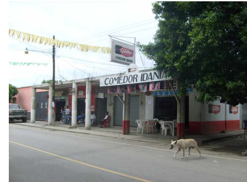
Fotografía No. 1 Fachada principal del mercado actual.
