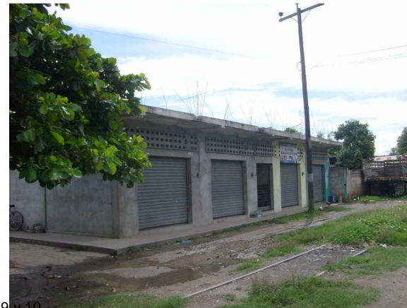
Foto 9 y 10 Esta es la parte de atrás, la cual puede ser aprovechada como área de carga y descarga, actualmente sólo tiene un local que es una carnicería, también se puede observar que necesita un tratamiento del suelo.
