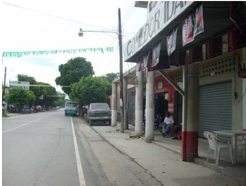
Foto 7: Aquí se puede observar la fachada frontal del actual mercado.
