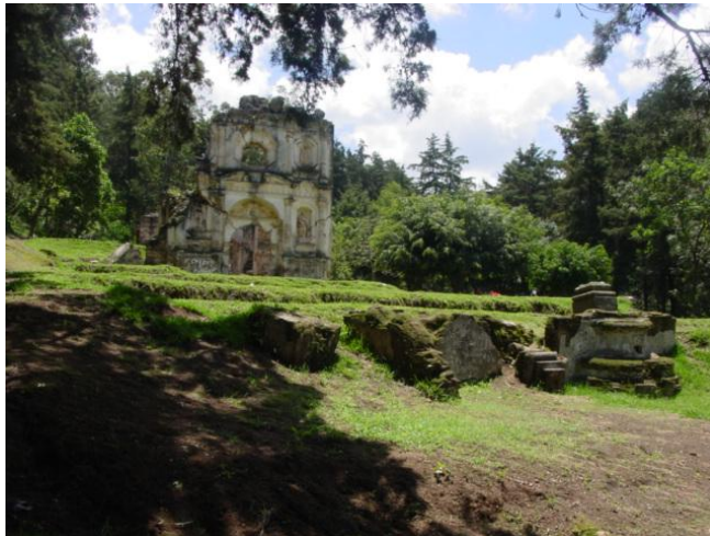
Ermita Dolores del Cerro. Vista actual de los restos de escalinatas y el atrio
