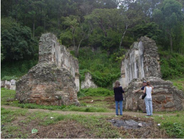
Restos de fachada principal
