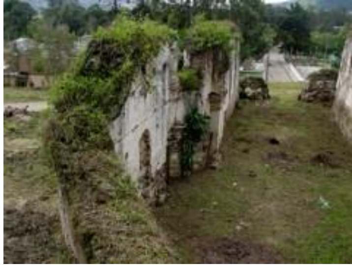
Vista de la nave desde el presbiterio,
