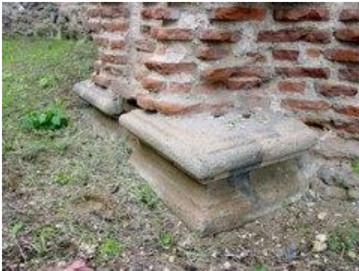
Pilastra del muro sur
