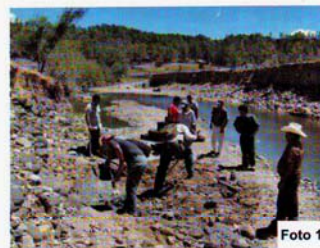
Foto 1. Limpieza y nivelación del terreno
