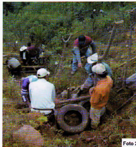
Foto 2. Colocación de las llantas y madera en la orilla para reforzar la estructura.
