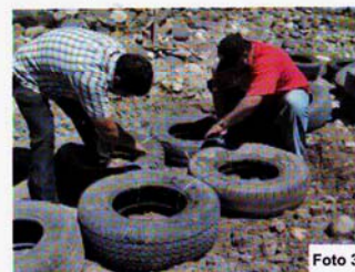
Foto 3. Llantas amarradas con alambre galvanizado calibre 14 y rellenas con piedras.
