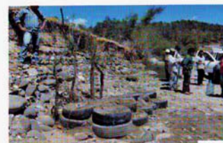
Foto 5. Sobre las llantas "cimiento" se colocan las otras hileras de llantas
