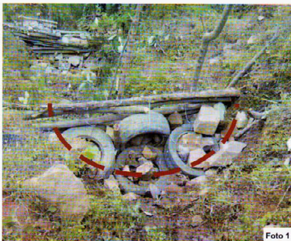
Foto 1. La línea punteada roja muestra la forma cóncava de la barrera
