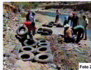
Foto 2. Colocación de llantas sobre terreno nivelado para conformar el cimiento.
