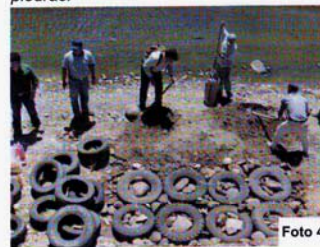
Foto 4. Llantas amarradas y llenas de piedras. Incluso se han colocado piedras en los espacios entre llantas. Sobre toda la estructura se colocará una mezcla de tierra con cemento, en la siguiente proporción: por cada 20 cubetas de arena x un saco de cemento.
