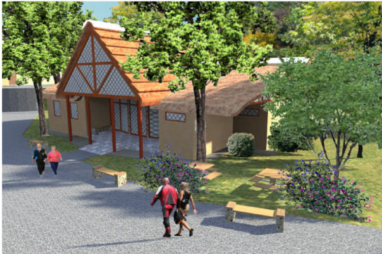
VISTA SURESTE ADMINISTRACIÓN
