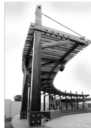
Fotografía No.113 Techo a un agua en voladizo Fuente: Desconocido
