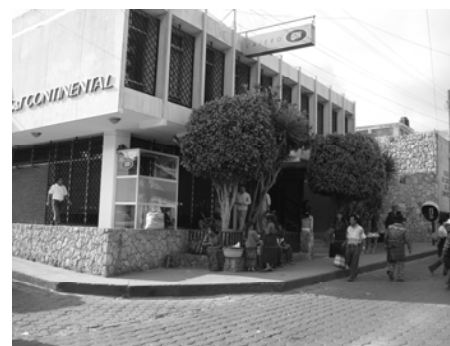
Fotografía No.69 7ma avenida y 9na calle Banquetas al 100% sin acceso para personas discapacitadas Fuente: Elaboración propia
