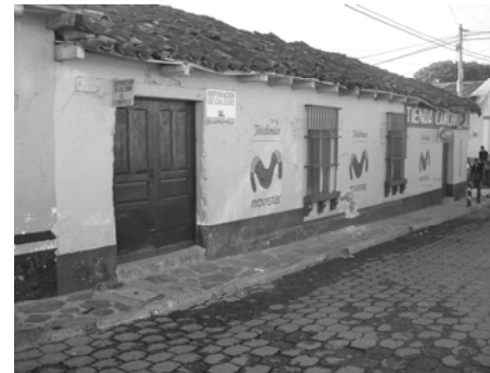
Fotografía No.94 7ma avenida y 12 calle Vivienda representativa Fuente: Elaboración propia
