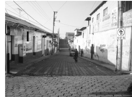
Fotografía No.78 7ma avenida y 11 calle Adoquinado en mal estado Fuente: Elaboración propia
