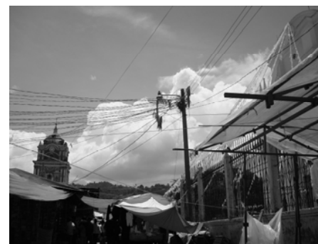
Fotografía No. 119 Tendido de cables Contaminación Visual frente a Iglesia Catedral Fuente: Elaboración propia
