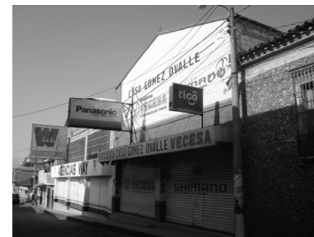
Fotografía No.101 7ma avenida y 8va calle Fuente: Elaboración propia
