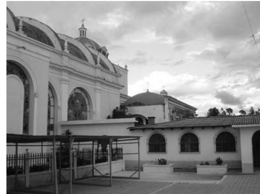
Fotografía No. 18 IGLESIA CATEDRAL Cúpula de Capilla Fuente: Elaboración Propia
