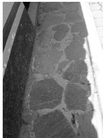
Fotografía No. 61 6ta avenida y 12 calle Textura de piedra Fuente: Elaboración propia
