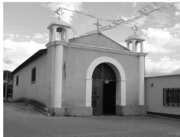
Fotografía No. 21 IGLESIA SAN BARTOLO Fachada de Iglesia Fuente: Elaboración Propia
