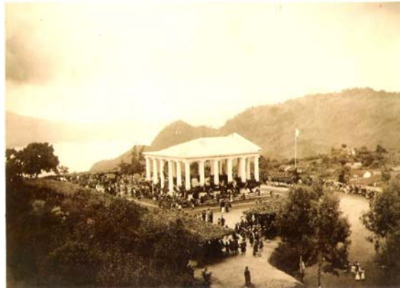
Fotografía No. 40 TEMPLO MINERVA Fotografía tomada para inauguración del Templo Minerva Fuente: Desconocido
