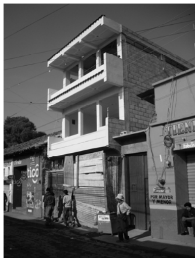
Fotografía No.97 7ma avenida y 10 calle Construcción de tres niveles Fuente: Elaboración propia
