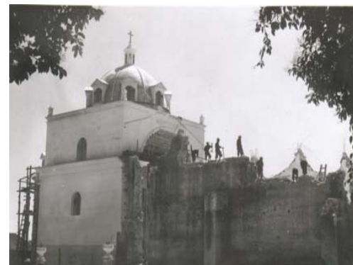
Fotografía No. 15 IGLESIA CATEDRAL Demolición de Iglesia Catedral año 1,967
