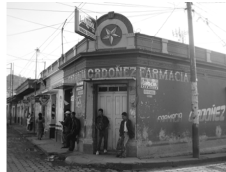
Fotografía No.95 7ma avenida y 10 calle Vivienda representativa Fuente: Elaboración propia
