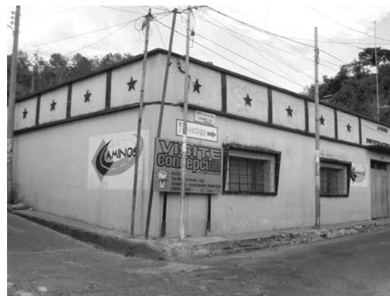
Fotografía No. 25 EDIFICIO DE CAMINOS Fachada frontal y lateral izquierda Fuente: Elaboración Propia
