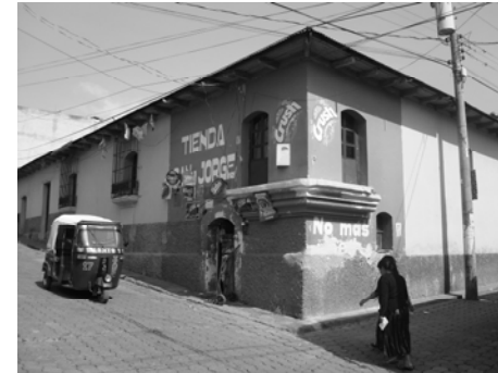
Fotografía No. 28 CASA DE HABITACIÓN 11va calle y 8va Avenida Fuente: Elaboración Propia
