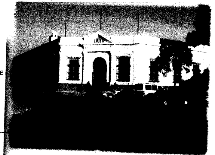
Vista del Instituto Normal para Varones de Occidente, con características arquitectónicas neoclásicas, sistema constructivo a base de mampostería de piedra. Ubicado sobre la Calle Rodolfo Robles.
