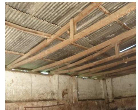
Figura 21 por su estado físico representa peligro de utilización fuente: elaboración propia
