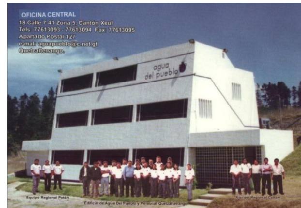
ILUSTRACIÓN No. 9 EDIFICIO DE OFICINAS CENTRALES DE AGUA DEL PUEBLO, QUETZALTENANGO.
