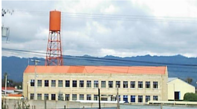
ILUSTRACIÓN No. 12 FACHADA SUR-ESTE
