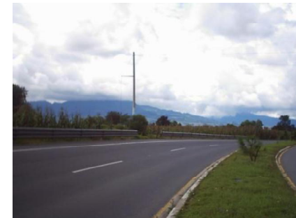
ILUSTRACIÓN No. 29.1 CARRETERA VISTA AL OESTE
