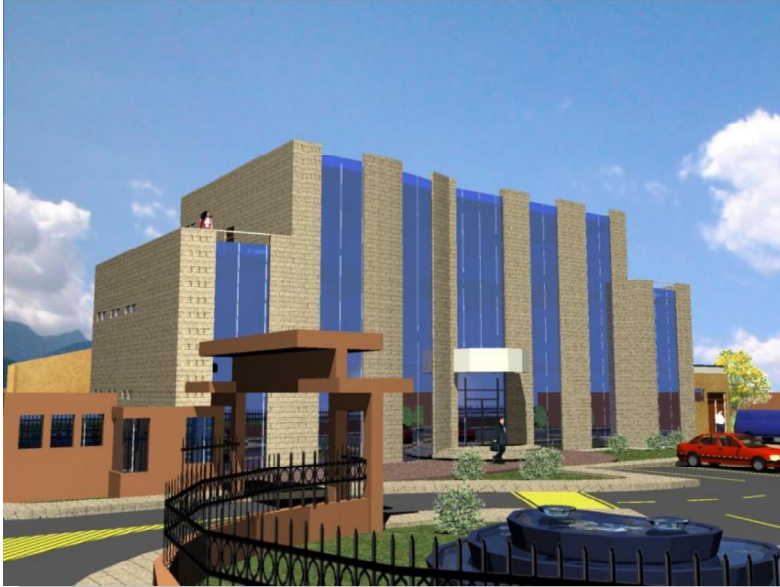
ILUSTRACIÓN No. 79 VISTA DE INGRESO Y FACHADA FRONTAL
