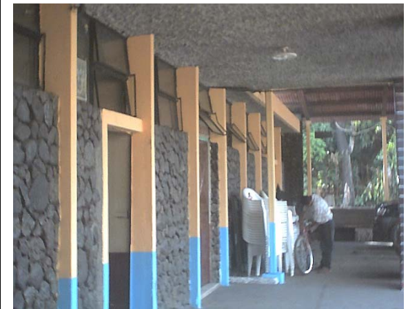
► Foto del ambiente exterior
