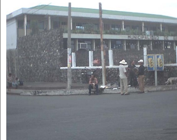
► Foto del ambiente exterior
