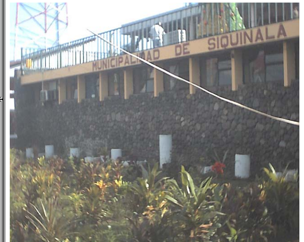
► Foto del ambiente exterior
