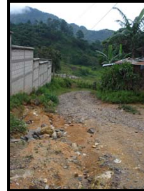
CALLE EN MAL ESTADO
