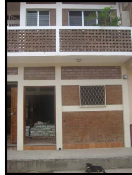
Fotografía No. 36 Ejemplo del impacto visual de Algunas edificaciones de Olopa Fotografías: Gustavo A Chacón
