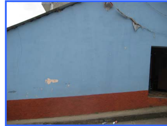
Fotografía No. 146 Zócalo acorde a la pendiente de la calle
