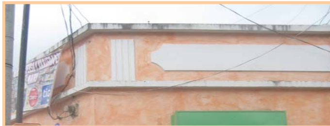
Fotografías No. 125 Suciedad en remates superiores de muros Fotografías: Gustavo A Chacón
