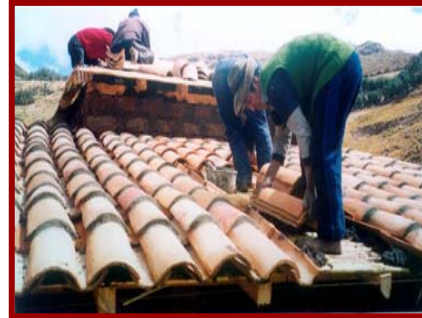
Colocación de tejas
