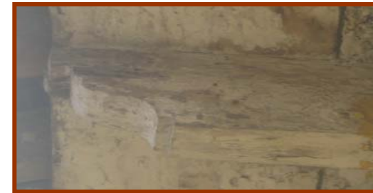
Fotografía No. 125 Detalles de pecho de paloma de las vigas de madera Fotografías: Gustavo A Chacón
