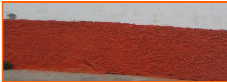
Fotografía No. 144 Zócalo de granceado
