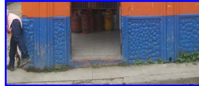
Fotografía No. 52 Zócalo de piedra bola Fotografía: Gustavo A Chacón
