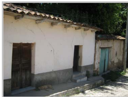
Fotografía No. 30 Edificaciones de bajareque Fotografías: Gustavo A Chacón
