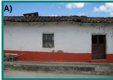
Fotografía No. 39 Edificaciones tipo “A” y “B” Fotografías: Gustavo A Chacón
