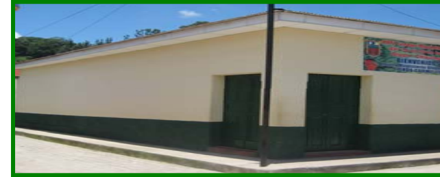
Fotografía No.127 Zócalo de granceado
