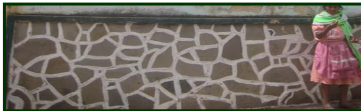
Fotografía No. 50 Zócalo de piedra laja y de azulejo Fotografías: Gustavo A Chacón
