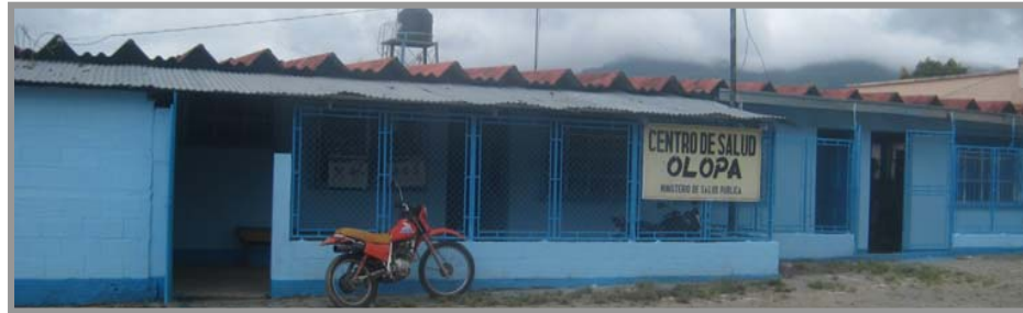
Fotografía No. 114 Techo de Duralita Fotografía: Gustavo A Chacón
