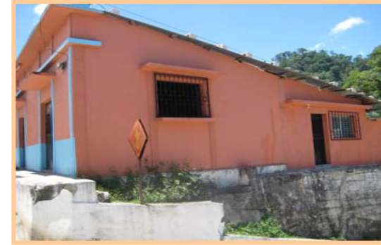
Fotografía No. 132 Banquetas deterioradas o áreas sin banqueta Fotografías: Gustavo A Chacón
