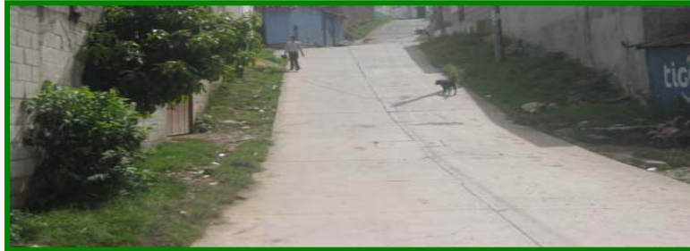
Fotografía No. 92 Ejemplo de gabaritos y banquetas Fotografías: Gustavo A Chacón
