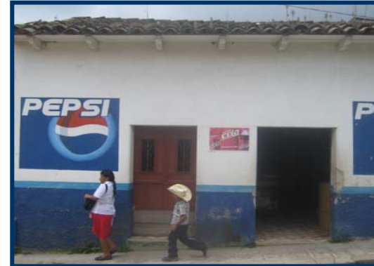
Fotografía No. 74 Edificación típica “A” y remate de Viga Fotografías: Gustavo A Chacón V
