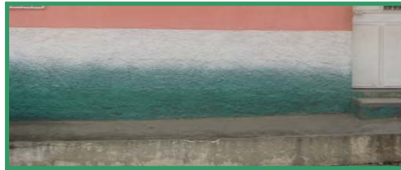
Fotografía No. 49 Zócalo de granceado Fotografía: Gustavo A Chacón
