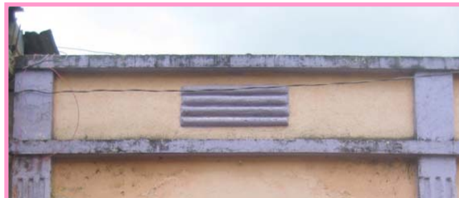
Fotografías No. 125 Suciedad en remates superiores de muros Fotografías: Gustavo A Chacón
