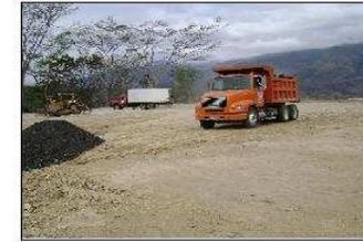
FOTO 7: Esta fotografía muestra que en sus plataformas hoy en día son planas con una pequeña inclinación de 1% de pendiente para facilitar el diseño del mismo para disuocar las aguas pluviales a la calle principal y con tuberías hacia el río motagua para que este conserve su estado actual.
