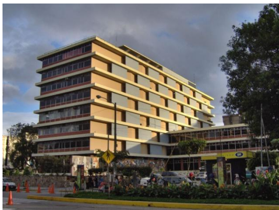
Edificio IGSS Oficinas Centrales, Ciudad de Guatemala
