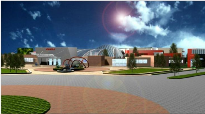
FACHADA PRINCIPAL DE CONJUNTO
