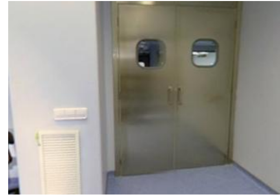
Quirófanos: Utilización de materiales adecuados para poder mantener la asepsia en el lugar. Buen control de ingreso y egreso de pacientes.
