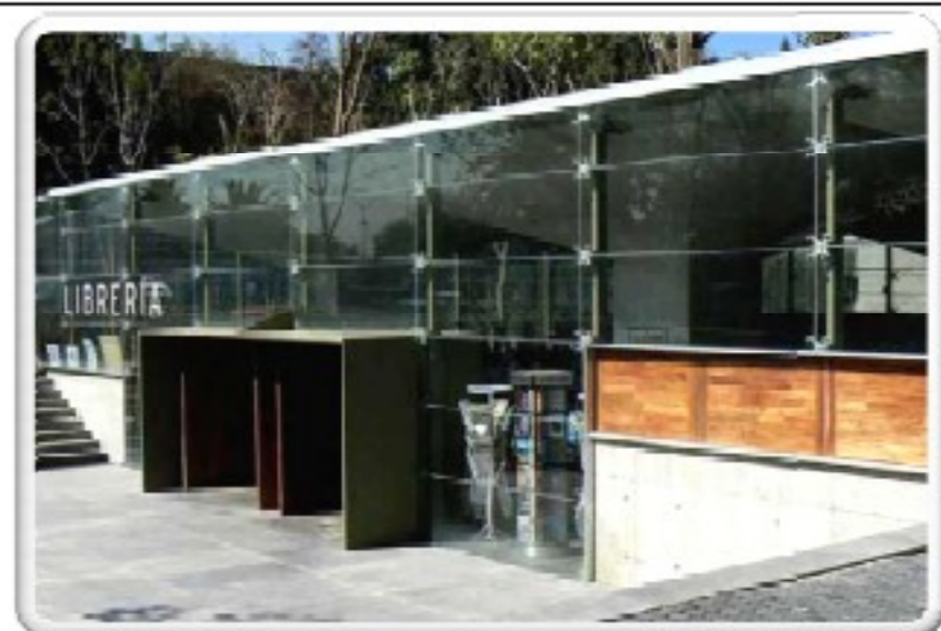
Exterior del Edificio
