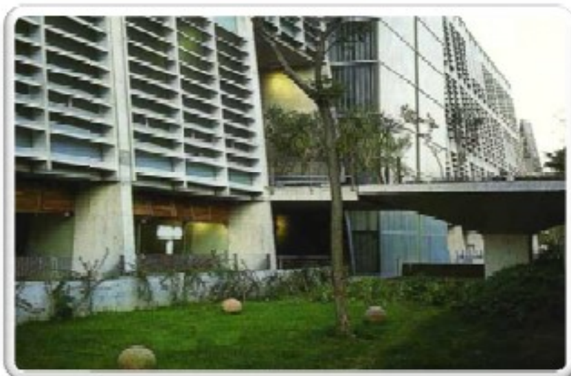
Exterior del Edificio
