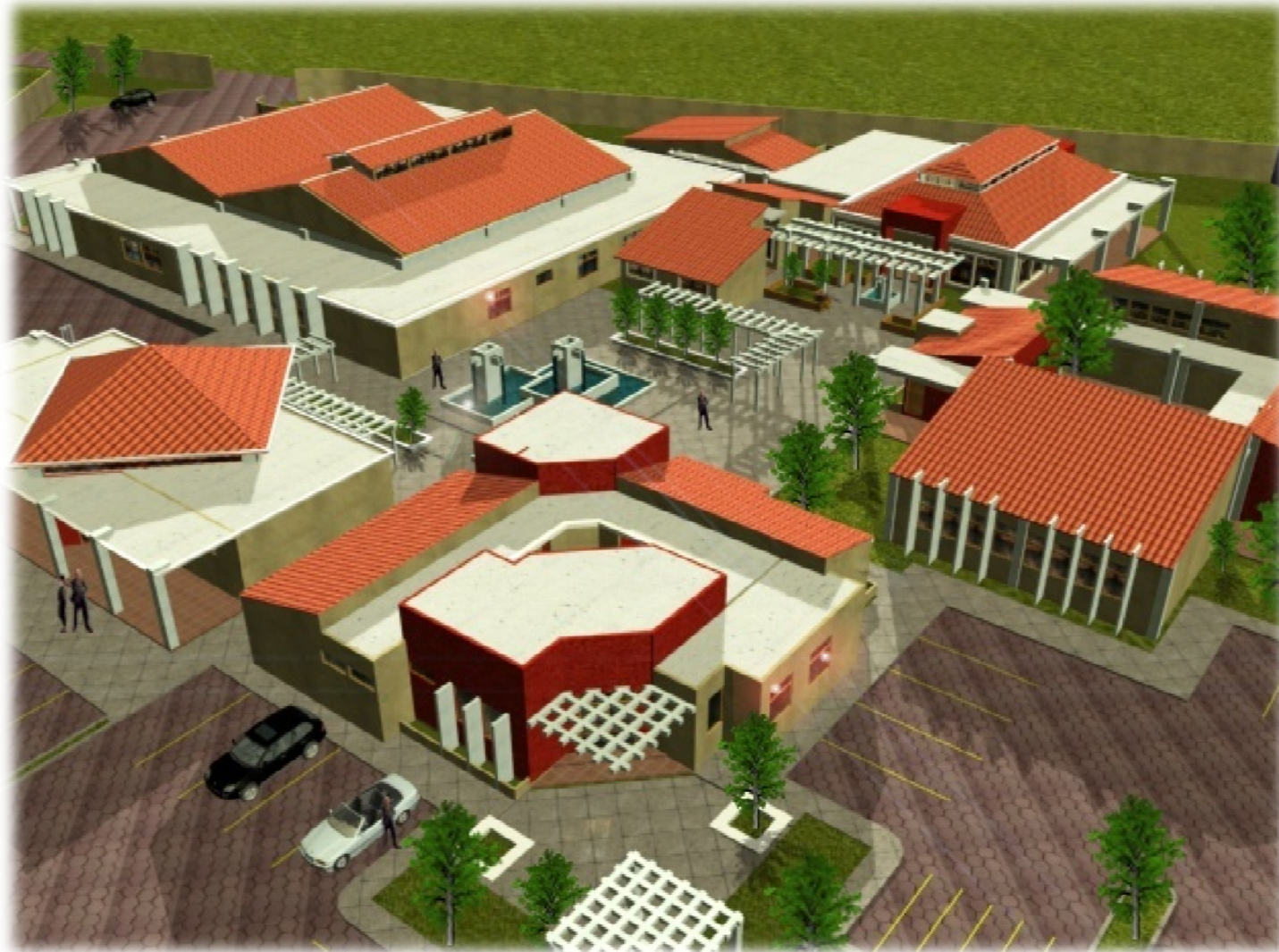
VISTA AEREA DEL CONJUNTO
