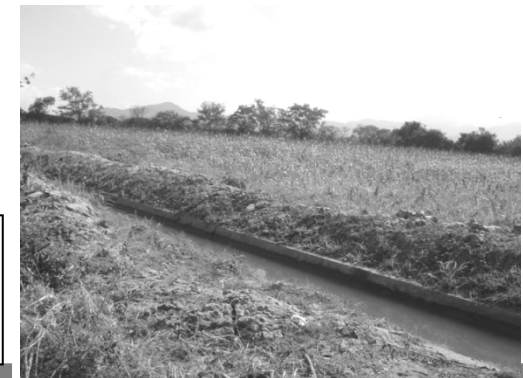
Fotografía 3.9: Sistema de riego por gravedad o canales. Fuente: EPSDA 2008-1 Gabriela Cruz
