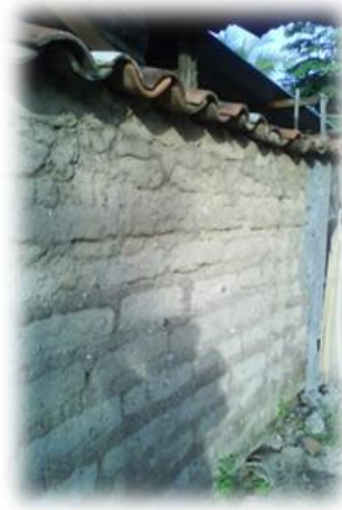
IMAGEN 11: Muro típico de la región, adobe. Fuente: Elaboración propia.
