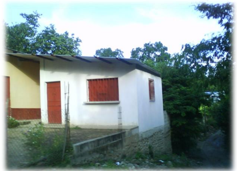
IMAGEN 10: Vivienda de concreto reforzado, techo de lámina de zinc y muro perimetral de malla. Fuente: Elaboración Propia.
