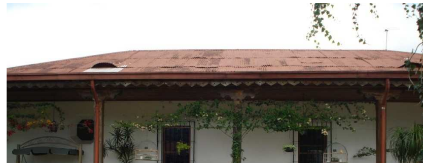
FOTOGRAFÍA No. 9 TECHO DE LÁMINA A. Aguilar Cabrera
