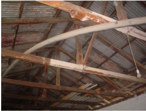
FOTOGRAFÍA No. 16 ESTRUCTURA DE MADERA A. Aguilar Cabrera
