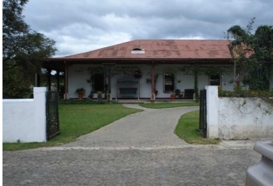
FOTOGRAFÍA No. 2 FACHADA SUR CASA PATRONAL A. Aguilar Cabrera
