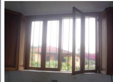
VENTANA EN LAVANDERÍA
