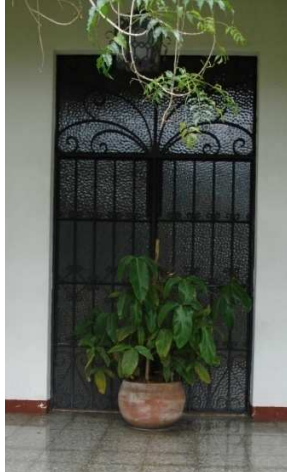
PUERTA INGRESO PRINCIPAL
