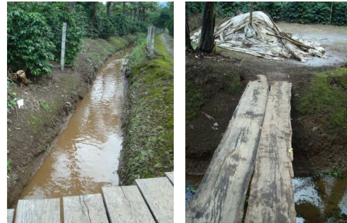
PASO DE ZANJAS DURANTE RECORRIDO ACTUAL
