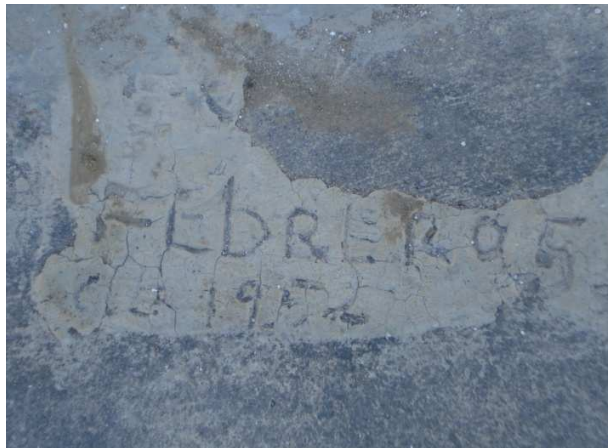
FOTOGRAFÍA No. 17 FUNDICIÓN DE PISO, FEBRERO, 5 DE 1,952 A. Aguilar Cabrera
