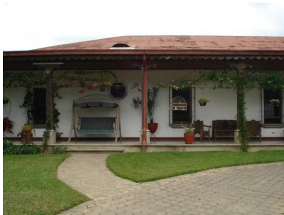
FOTOGRAFÍA No. 2 INGRESO LATERAL SUR A. Aguilar Cabrera
