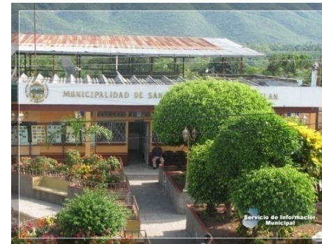
Imagen No. 42: Se puede observar las alturas de techos: en parte posterior de Cancha Polideportiva y al frente del Edificio Municipal.
