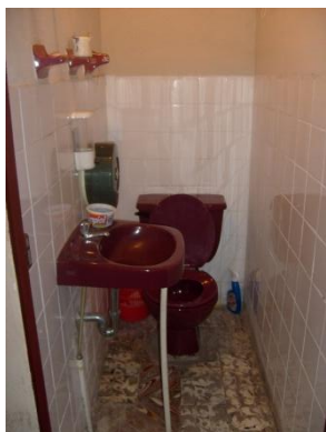
Imagen No.4: Los baños utilizados por la corporación colindan con una de las calles y no poseen iluminación ni ventilación.
