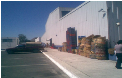
Área carga y descarga, (foto 31) Calle Principal, (noviembre 2,008) Fuente Propia.
