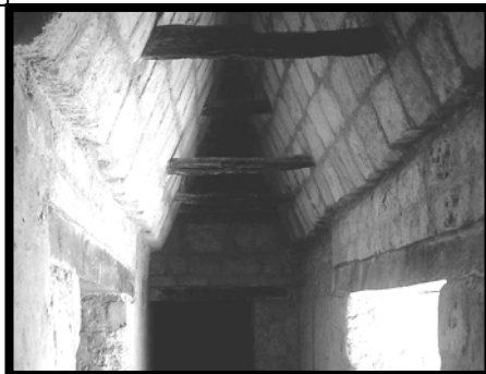
Fotografía 8 Bóveda de Edificio 375 Yaxha Fuente: Aníbal Monterroso
