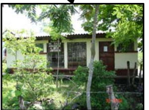
Puesto de Salud cercano a la Vía del Tren.
