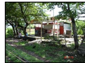
En lo que fuera una subestación de la Vía Tren hoy se levanta una caseta y una venta de licores.
