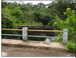
PUENTE MILLA 58.00 INICIO DEL TRAMO EN ESTUDIO
