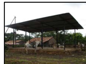
En lo que fuera una subestación del Tren hoy se encuentra un establo.
