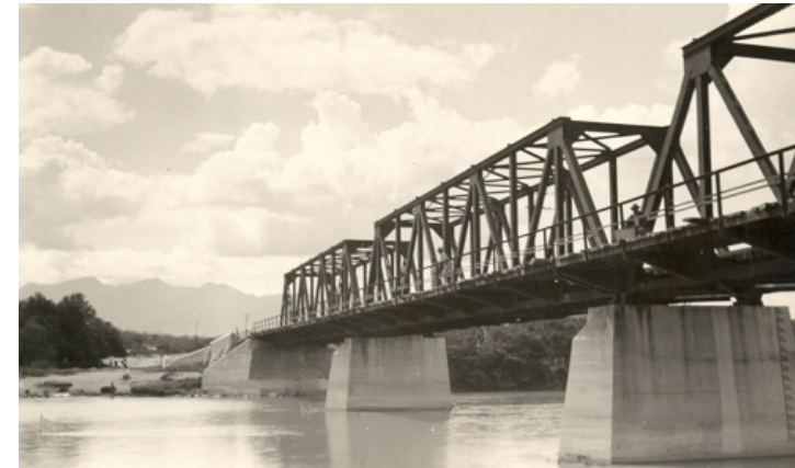
Ilustración 3 Puente Negro sobre el río Grande de Zacapa. Fuente: Carlos Torres.
