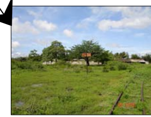
Vista de la Vía Tren cubierta de maleza y en constante deterioro
