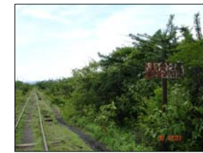
Unos de los pocos rotulos que quedan de la vía ferrea los cuales se encuentran en deterioro
