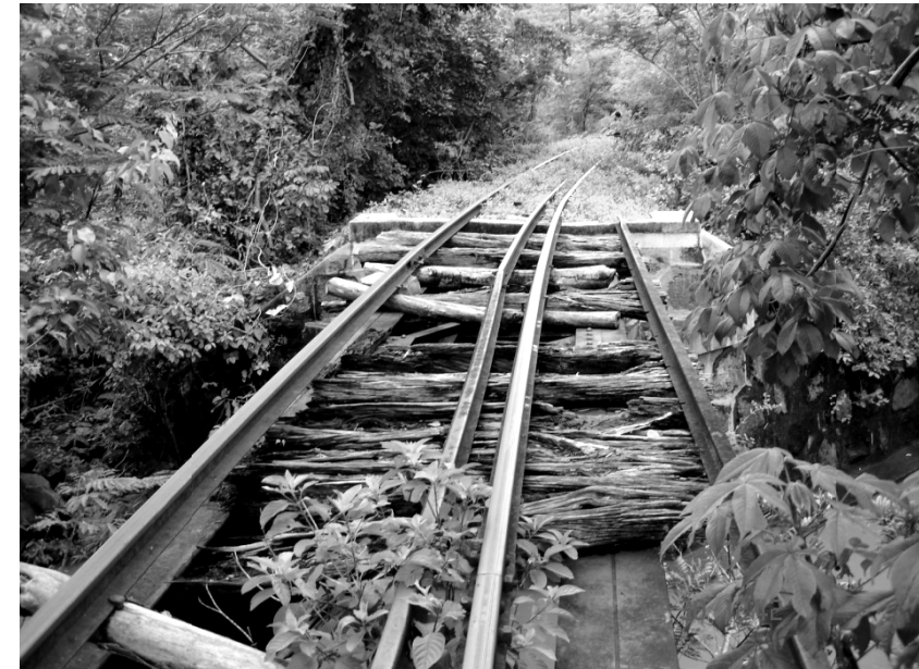
Ilustración No. 7 Puente milla 68.56
