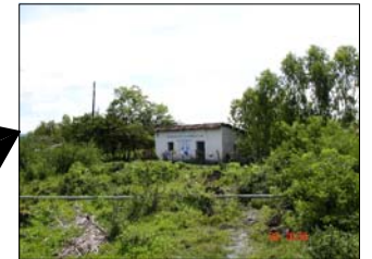
OFICINA MIGRATORIA UBICADA EN LA ESTACIÓN ANGUIATÚ EN TOTAL DETERIORO
