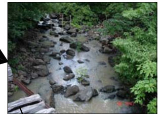
PUENTE UBICADO EN LA MILLA 68.56
