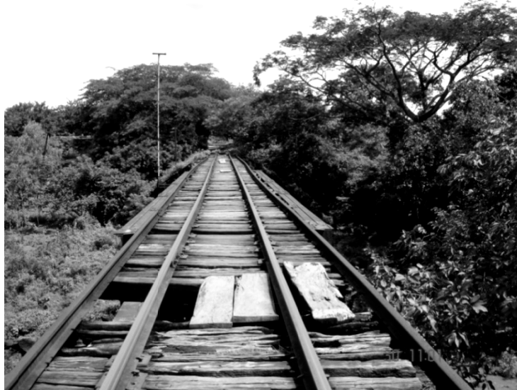
Ilustración No. 6 Puente Fronterizo milla 70.3
