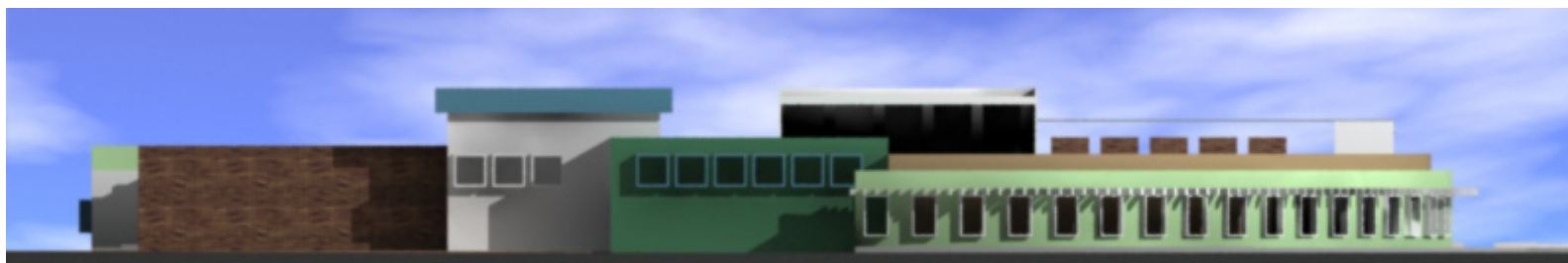
FACHADA LATERAL OESTE
