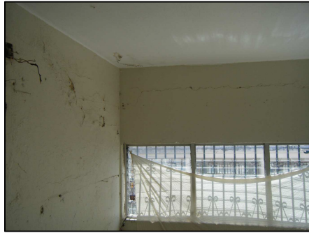
Fotografía No.64: Edificio San Carlos
