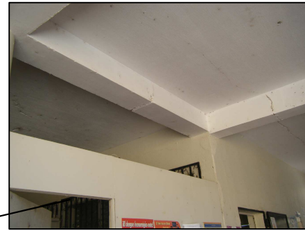
FOTOGRAFIA No. 98. FISURAS EN LOSA ELABORACIÓN PROPIA.
