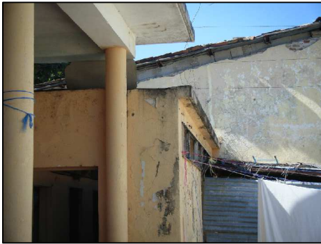
Fotografía No. 86 : Edificio San Carlos
