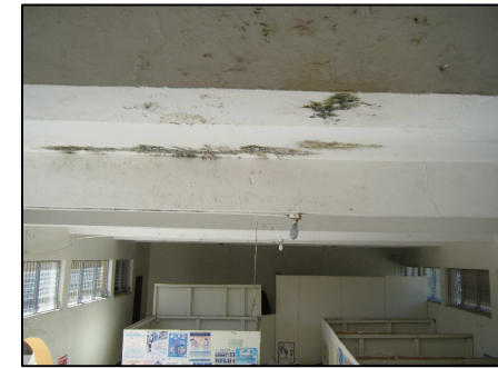
Fotografía No.66: Edificio San Carlos
