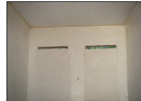
Fotografía No. 85 : Edificio San Carlos
