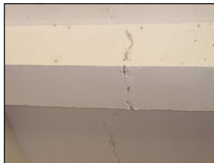
Fotografía No. 73: Edificio San Carlos
