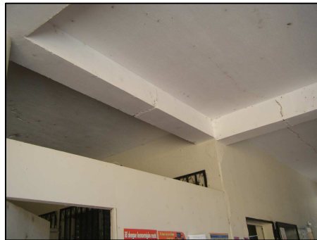
Fotografía No.68: Edificio San Carlos
