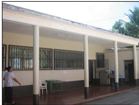
Fotografía No. 60: Edificio San Carlos
