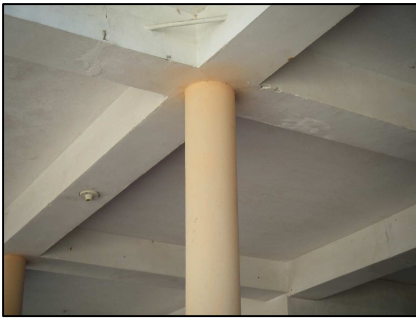
Fotografía No.69: Edificio San Carlos
