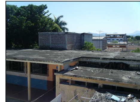
Fotografía No. 77: Edificio San Carlos
