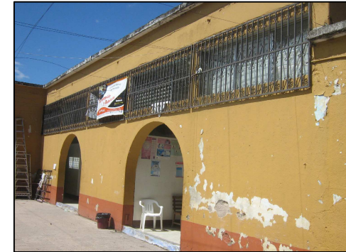
Fotografía No. 59: Edificio San Carlos
