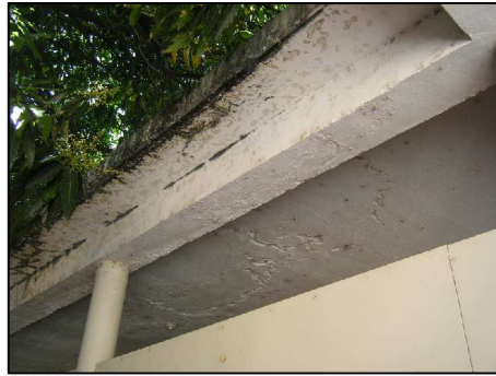
Fotografía No.67: Edificio San Carlos
