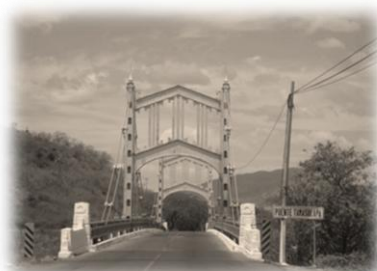
Fotografía: 5 Puente Tamzulapa
