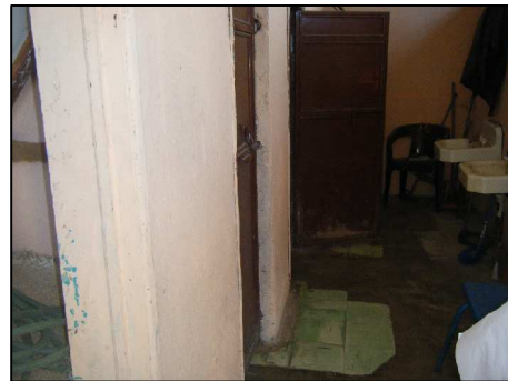
Fotografía No. 83 : Edificio San Carlos
