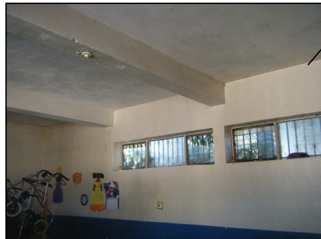
Fotografía No. 61: Edificio San Carlos
