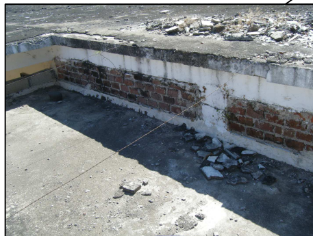
Fotografía No. 84 : Edificio San Carlos
