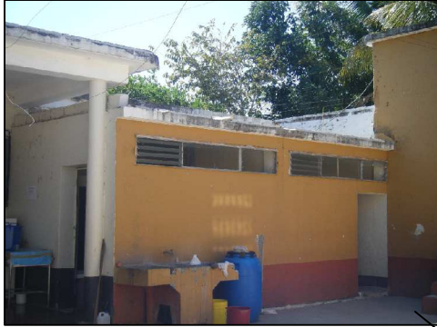
Fotografía No.57: Edificio San Carlos
