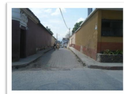
Fotografía No. 2: Vista sobre la fachada lateral del antiguo edificio de San Carlos de Borromeo. (Sur)
