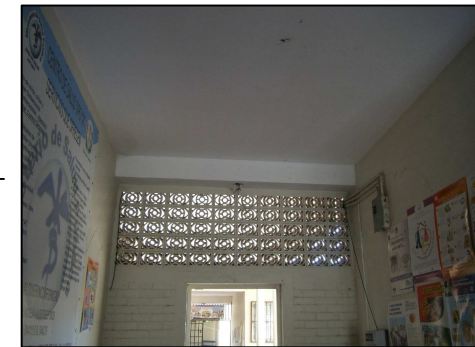
Fotografía No. 90 : Edificio San Carlos
