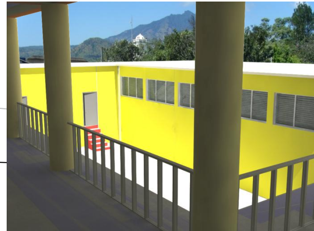
Vista del área exterior desde segundo nivel
