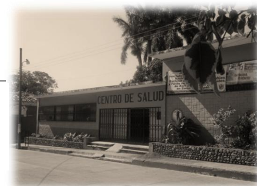
Fotografía No. 97. Vista frontal del antiguo edificio de San Carlos de Borromeo.
