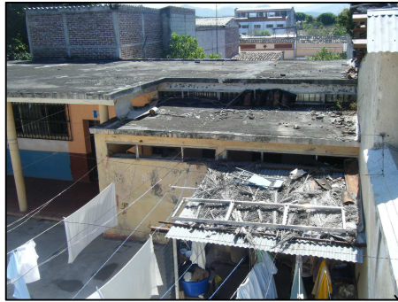
Fotografía No. 75: Edificio San Carlos
