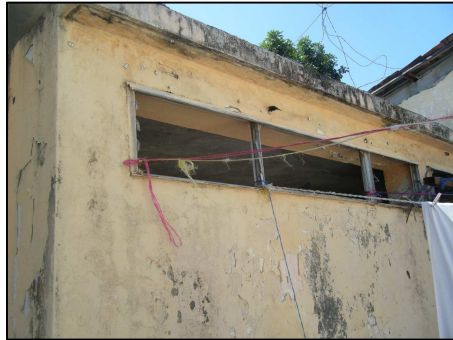
Fotografía No. 80: Edificio San Carlos
