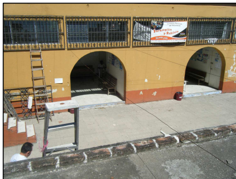
Fotografía No. 89 : Edificio San Carlos
