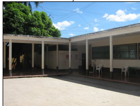
Fotografía No. 62: Edificio San Carlos
