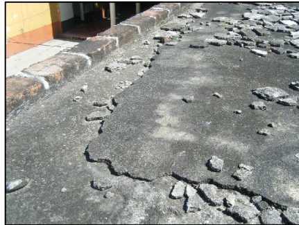
Fotografía No. 78: Edificio San Carlos
