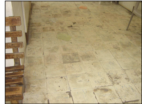
Fotografía No. 88 : Edificio San Carlos
