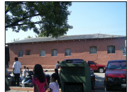
Fotografía No. 43: Vista de la 2da. calle (fachada este). Se observan los basureros a las orillas de la plaza central. Al fondo casa parroquial.
