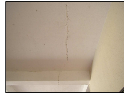
Fotografía No. 71: Edificio San Carlos
