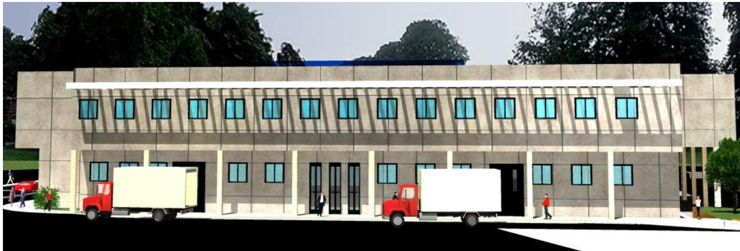
FACHADA ESTE (Terminado)
