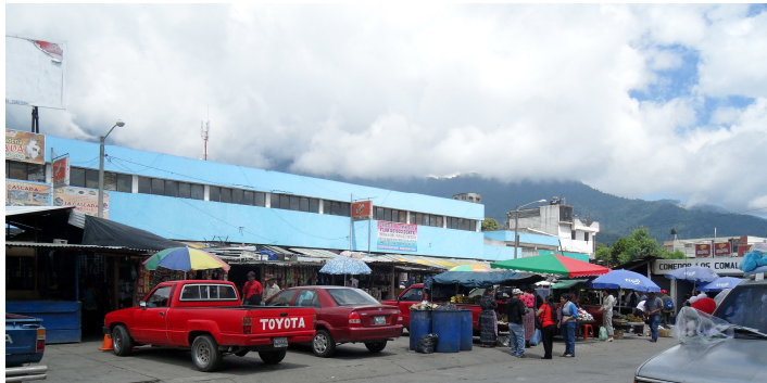
Foto 2. Mercado de San Marcos, colapsado y en desbordamiento.
