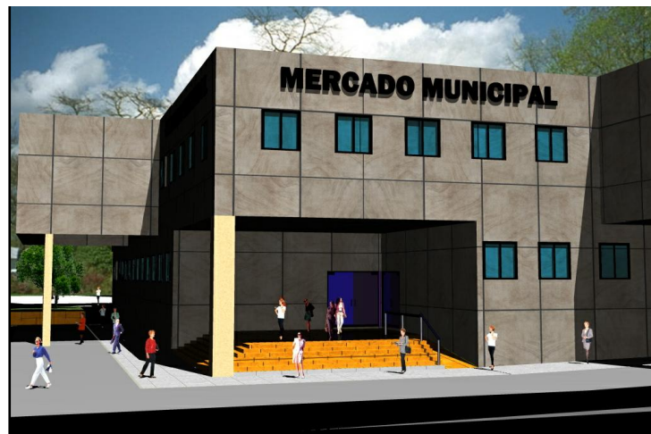
INGRESO PEATONAL (Terminado)
