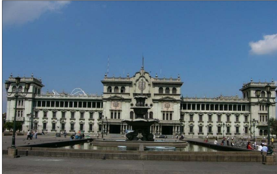
VISTA GENERAL DEL PROYECTO
