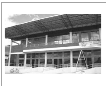
3.4.4.-F26. Fotografía donde se observa la Terminal de Buses Extraurbanos, imponiendo acertadamente un estilo vanguardista para la ciudad conservadora.
