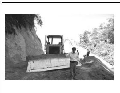
2.1.-F5. Propiciar carreteras como ésta que comunica con la Aldea El Bojonal, ayudan al desarrollo de nuestros pueblos. FUENTE: elaboración propia.
