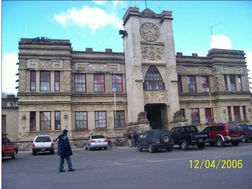
VISTA GENERAL DEL PROYECTO
