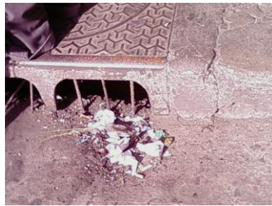
Fotografía 82. 6ª. Avenida entre 12 y 13 calles. La acumulación de desechos sólidos, es evidente. Autor: Mario Sánchez.
