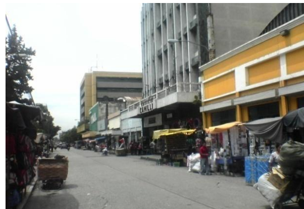
Fotografía No. 2. 6ª. Avenida y 13 calle. Vista actual de la 6ª. Avenida del Centro Histórico, la presencia de ventas de comercio popular ha generado un deterioro en la imagen urbana. La presencia de arquitectura de distinta época genera que como Centro Histórico, éste pierda su valor. Autor: Mario Sánchez
