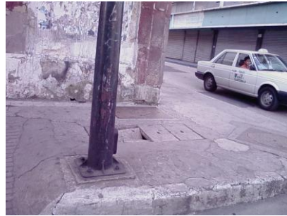
Fotografía 58, 6ª. Avenida entre 12 y 13 calles. El ancho de banquetas no es el adecuado. Autor: Mario Sánchez.
