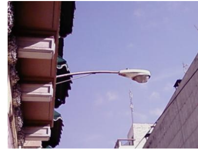
Fotografía 73. 6ª. Avenida entre 12 y 13 calles. Las lámparas de iluminación están adosadas al muro. Autor: Mario Sánchez.
