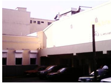
Fotografía 84. 6ª. Avenida entre 12 y 13 calles. La alineación con respecto a la calle se debe mantener, no como en este caso.
