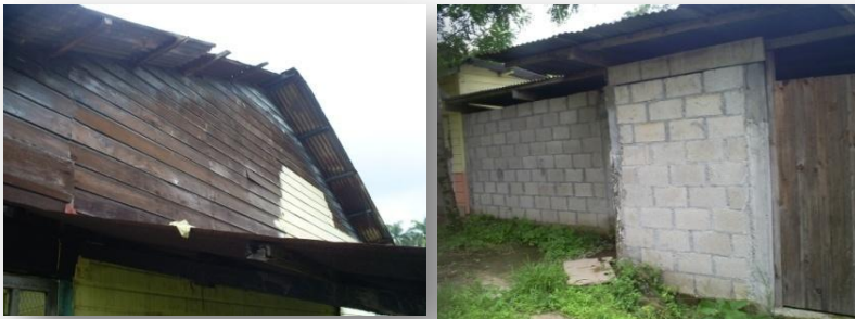
FOTOGRAFÍAS 49 y 50. En la primera se observa el color original de los muros, tanto de mampostería como los de madera. Y en la segunda los nuevos módulos que construyeron.
