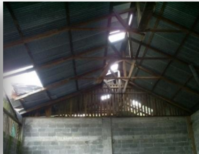
FOTOGRAFÍAS 41 y 42. En la primera se observa parte de la maquinaria que aún se conserva. En la segunda el desprendimiento de parte de la cubierta. FUENTE PROPIA
