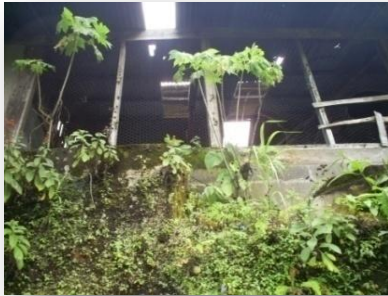
FOTOGRAFÍAS 39 y 40. La primera muestra el deterioro de la fachada y el lugar donde estaba la rueda. Y la segunda muestra el crecimiento desmedido de micro y macro flora, así como el desprendimiento de materiales. FUENTE PROPIA
