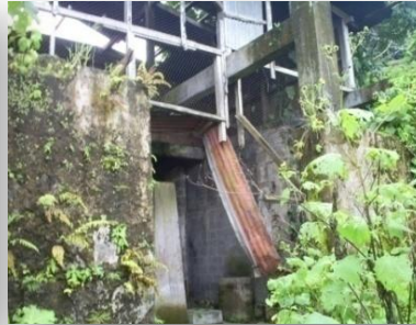
FOTOGRAFÍAS 39 y 40. La primera muestra el deterioro de la fachada y el lugar donde estaba la rueda. Y la segunda muestra el crecimiento desmedido de micro y macro flora, así como el desprendimiento de materiales. FUENTE PROPIA
