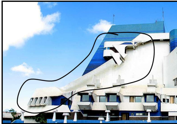
Foto No.16 Fachada del Centro Cultural Miguel Ángel Asturias, zona 4 Guatemala.
