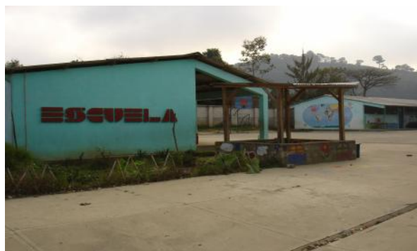
Escuela Rural ubicada en la entrada a San Mateo Milpas Altas Foto Tomada: Henry R. Domínguez S.
