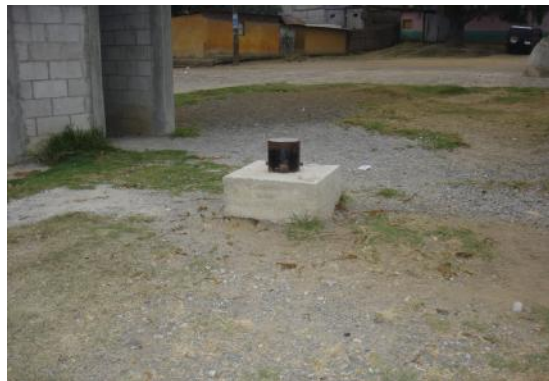
Tanque de agua potable esta ubicado en el parque central de San Mateo Milpas Altas. Foto Tomada: Henry R. Domínguez S.
