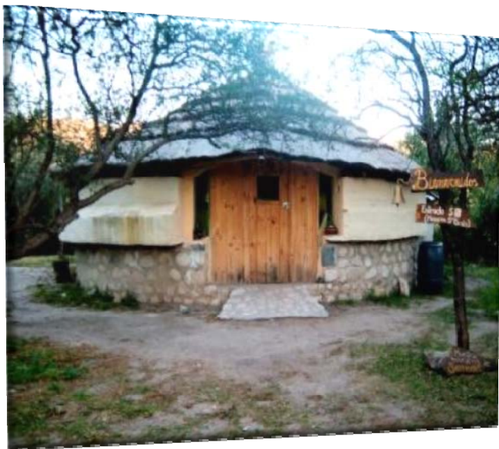
(Imagen No. 7) Fachadas del edificio utilizado para serpentario en Machagway. 11
