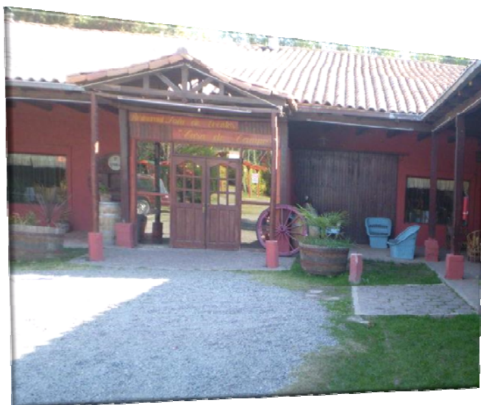
(Imagen No. 11) Entrada principal al Salón de Eventos, cubierta de teja y acabados en Madera. 16
