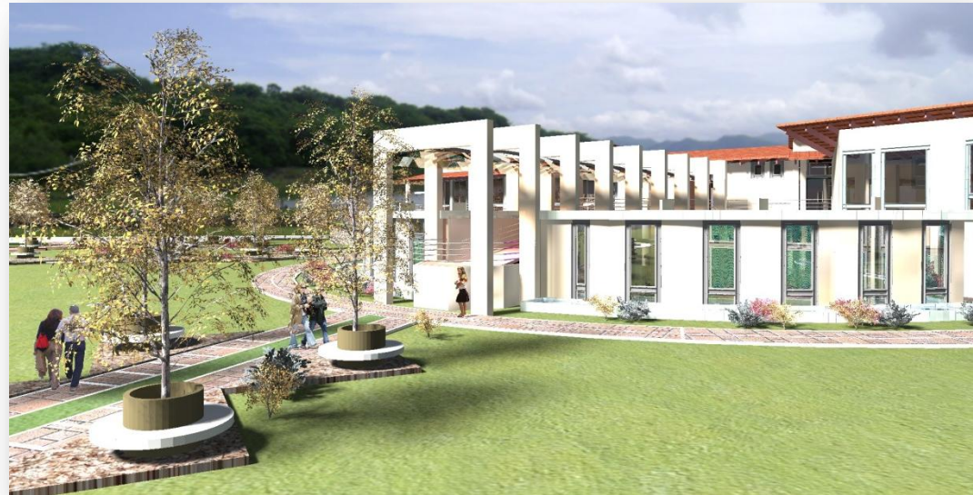
RAMPA DE ACCESO
