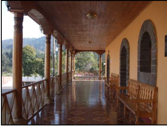
Foto: 3.3.1 -F (44) Columnas. Estilo Colonial En la imagen pasillo de la Municipalidad de San José Chacayá, en la cual se observan columnas de forma circular y de madera, colocadas sobre una base de piedra, características del estilo colonial.
