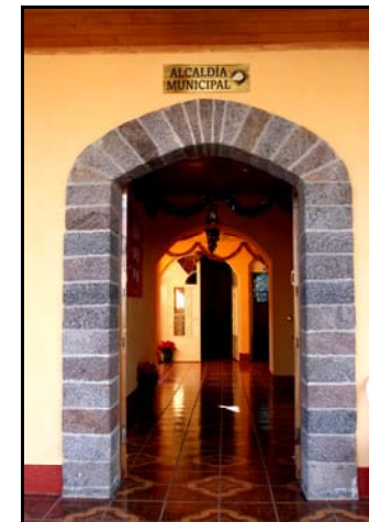
Foto: 3.3.1 – F (43) Entradas con Arcos de Medio Punto. Son las más utilizadas en la arquitectura del municipio, en la imagen se aprecia una de las entradas hacia el edificio municipal, la cual posee arcos a medio punto, recubiertos de piedra.
