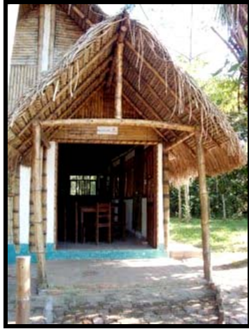
Foto: 1.3.2 (F 26) Restaurante. Brinda servicios de alimentación tanto para los huéspedes del Eco Albergue, como para los visitantes que lo soliciten con anticipación
