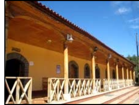
Foto: 3.3.1 – F (42) Edificio Municipal, situado en la cabecera municipal, en el cual se aprecia una arcada a lo largo de toda su fachada, así como también las columnas de forma circular, características del estilo colonial. La arcada del edificio sirve para delimitar la plaza central del edificio, formando con ello un pasillo de distribución a los diferentes ambientes que este ofrece.
