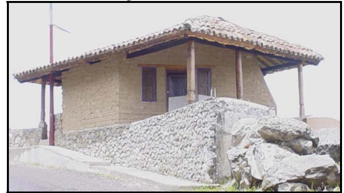
Foto: 3.3.2 -F (47) Elementos característicos de la construcción. Construcción ubicada en la salida de Panajachel hacia Santa Catarina Palopó, la cual utiliza artesanado de teja y madera, columnas de madera cuyas bases de piedra sostienen la cubierta de los corredores, así como muros de piedra y adobe expuesto, refuerzo de madera en los dinteles de puertas y ventanas. Foto: Netzer Ramírez
