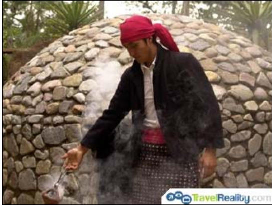
Foto 1.3.4 (F35) Temascal O Tuj. En la imagen Temascal tradicional, o especie de sauna utilizada por los indígenas, construido con piedra, lo que permite mayor absorción al calor.
