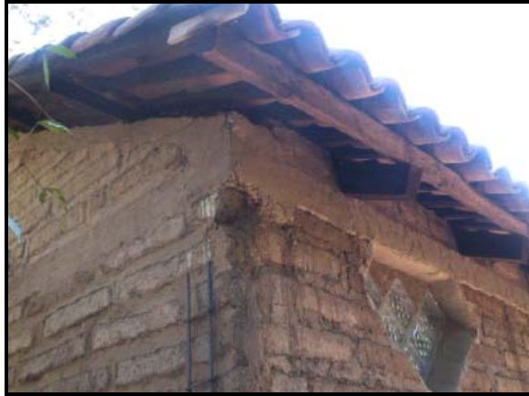
Foto: 3.3.2 -F (45) Construcción ubicada en la salida de Panajachel hacia Santa Catarina Palopó. La cual utiliza artesanado de teja y madera, columnas de madera en bases de piedra, muros de piedra y adobe expuesto, refuerzo de madera en los dinteles de puertas y ventanas. Foto Netzer Ramírez
