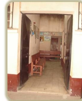
FOTO: No. 20 Ingreso a clínicas 2da. Fase Toma y Diseño: Propio
