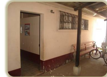
FOTO: No. 21 Pasillo techado con lámina Toma y Diseño: Propio
