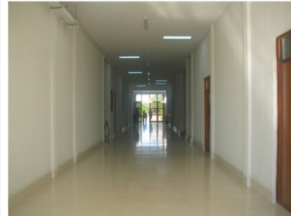
Fotografía 2. Pasillo del interior del Hospital Regional San Juan Bautista
