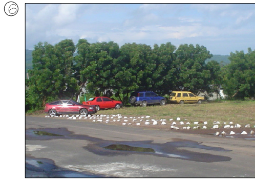
NO EXISTE DISEÑO DE PARQUEO TANTO TRABAJADORES COMO VISITANTES SE PARQUEAN FRENTE AL HOSPITAL
