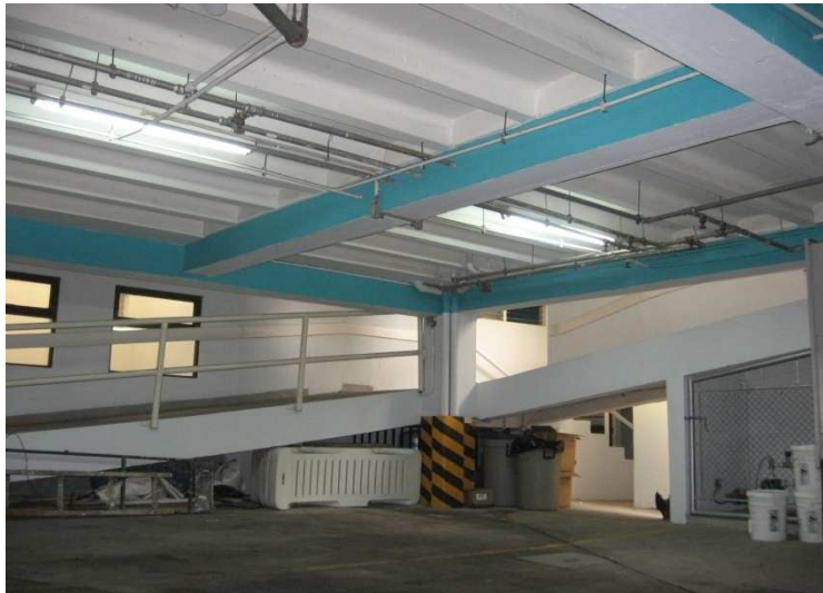
Foto No. 24 RAMPA DE EMERGENCIA
