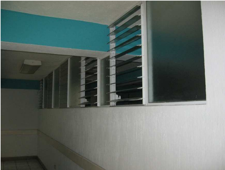
Foto No. 26 VENTANERÍA
