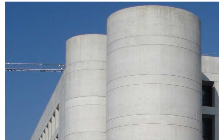
Foto No. 54 Precisión en acabados
