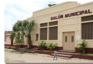
Foto No. 1.5.1 F-2 Salón Municipal. Utilización de block y techo de lámina a dos aguas.
