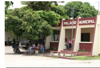
Foto No. 1.5.1 F-3 Edificio Municipal. Construcción de block con techo de losa plana.
