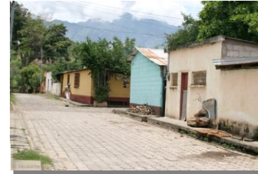
Foto No. 1.5.1 F-1 Viviendas particulares. Construcción con losa plana o techo a dos aguas.
