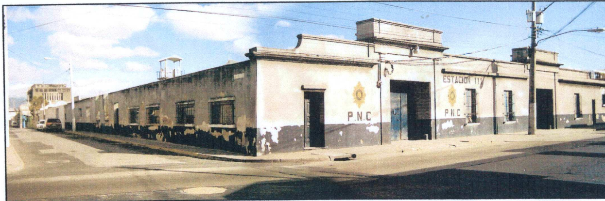
IMAGEN ACTUAL SOLAR 11 AV. Y 14 CALLE "A" PARA EL PARQUE EL CARROCERO
