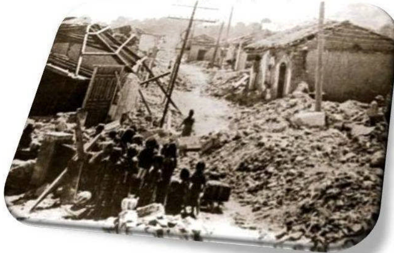
Foto 1.1.4.1 Foto 7 TERREMOTO DE GUATEMALA EN 1976
